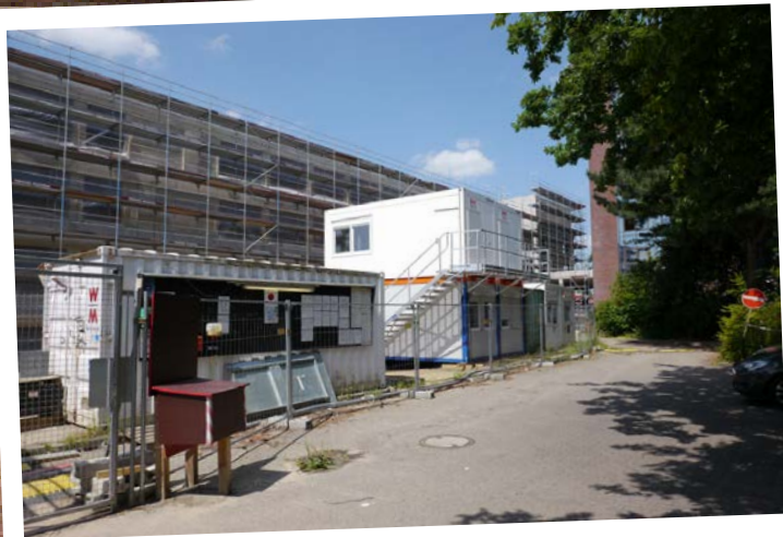
Baufortschritt Zentrum für Altersmedizin
